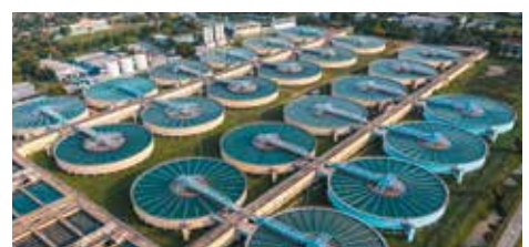
Ausrüstung für die Abwasserbehandlung
