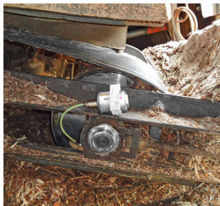
Die Y-Spannlagereinheit eines Förderbandes wird kontinuierlich mit Fett versorgt.
